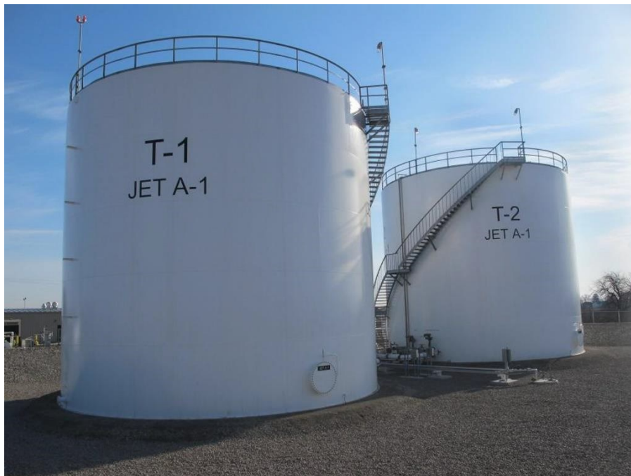
Рис. 2.5. Резервуари для зберігання реактивного палива Jet A-1 [45].
